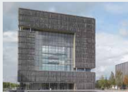
Главный офис компании ThyssenKrupp AG, Эссен
