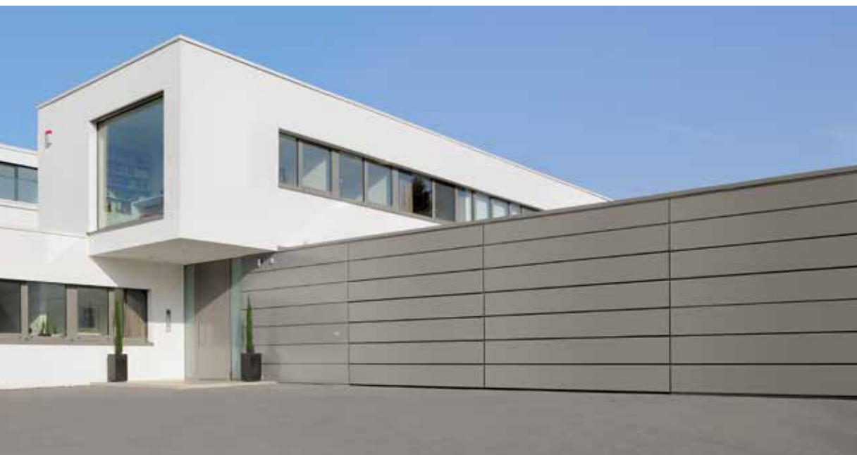
Облицовка алюминиевой соединительной пластиной, выполняемая заказчиком
